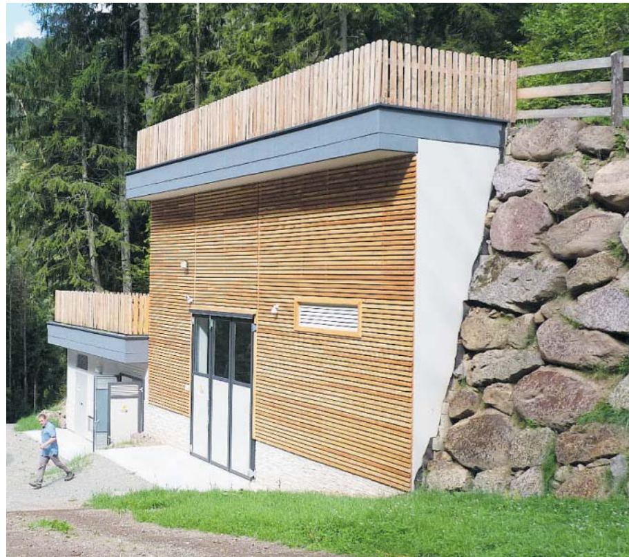
Das neue kleine Wasserkraftwerk: Links die Trafostation, rechts das Turbinenhaus
